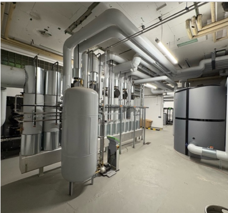
Ersatz Gasheizung durch Fernwärme
